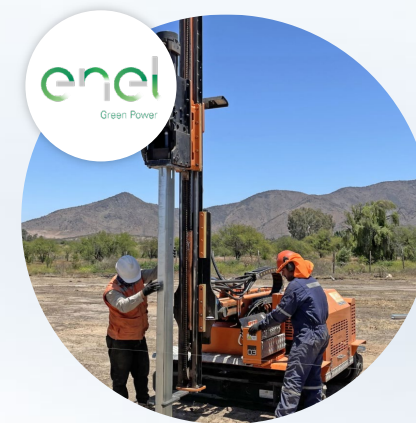
Hincas Proyecto Campos del Sol
