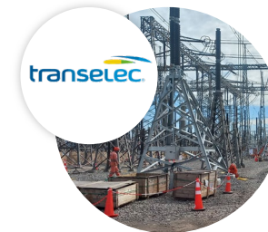
Renovación Subestación Buin
