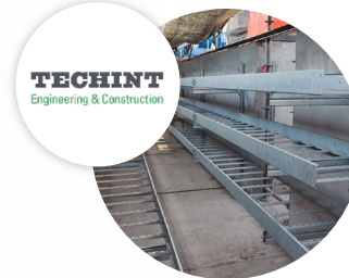
Estaciones de bombeo desalinizadoras
